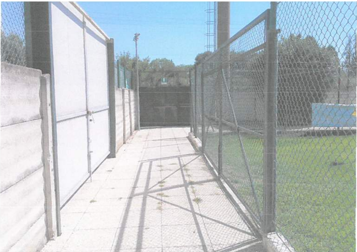
Ingresso mezzo di soccorso
